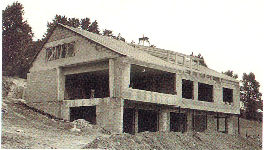
Der Rohbau - hier kurz nach dem Richtfest - läßt die Dimension des Hauses erkennen.
