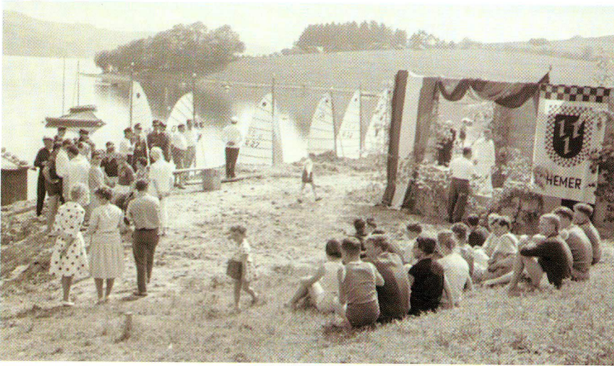
Unter unsäglichen Mühen und dem Einsatz der Mitglieder wurde das eigene Clubhaus an der Sorpe errichtet.
